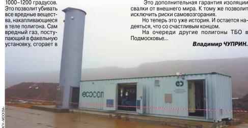
ней моментально, в течение 0.3 секунды. А завод по утилизации полностью автоматизирован и управляется с компьютера, где на дисплее в режиме реального времени отображаются все стадии процесса.
