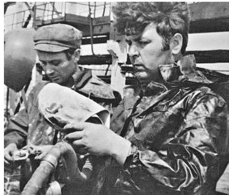
Иосиф Душанек на строительстве ПК «Шесхарис».
