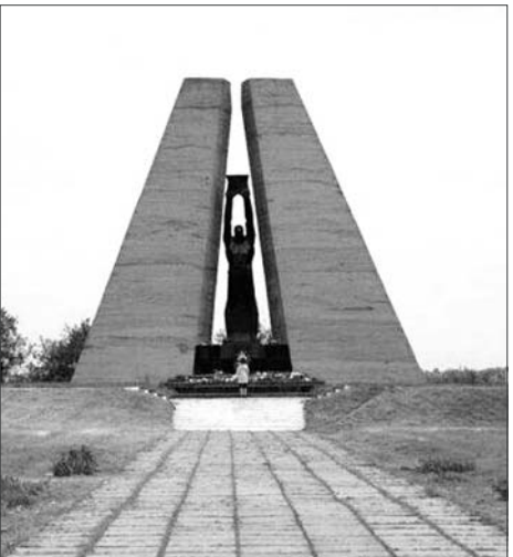
К реконструкции приступят в мае следующего года.
